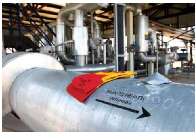
Коммерциялық мұнай есептеу торабы (КМЕТ) / Коммерческий узел учета нефти (КУУН) / Metering Unit
