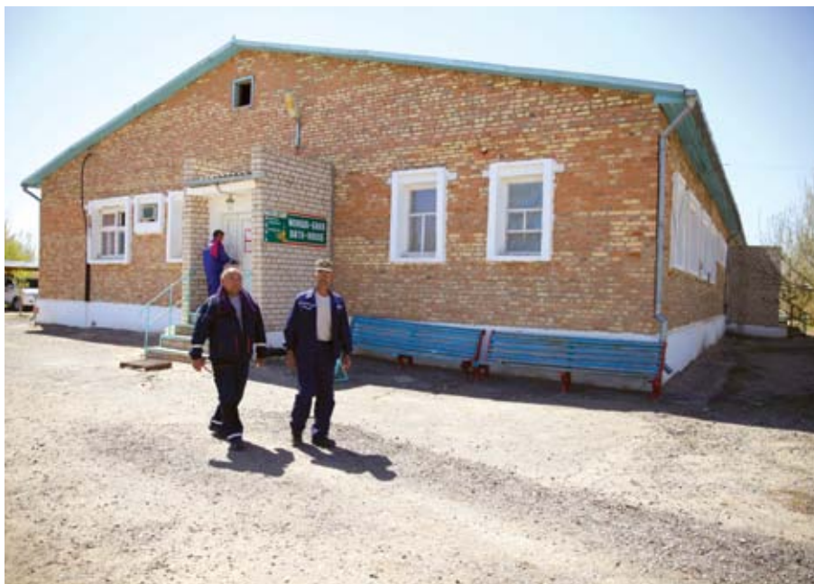
Құмкөлдегі монша-кір жуу кешені / Банно-прачечный комплекс на Кумколе / Sauna and laundry unit at Kumkol
