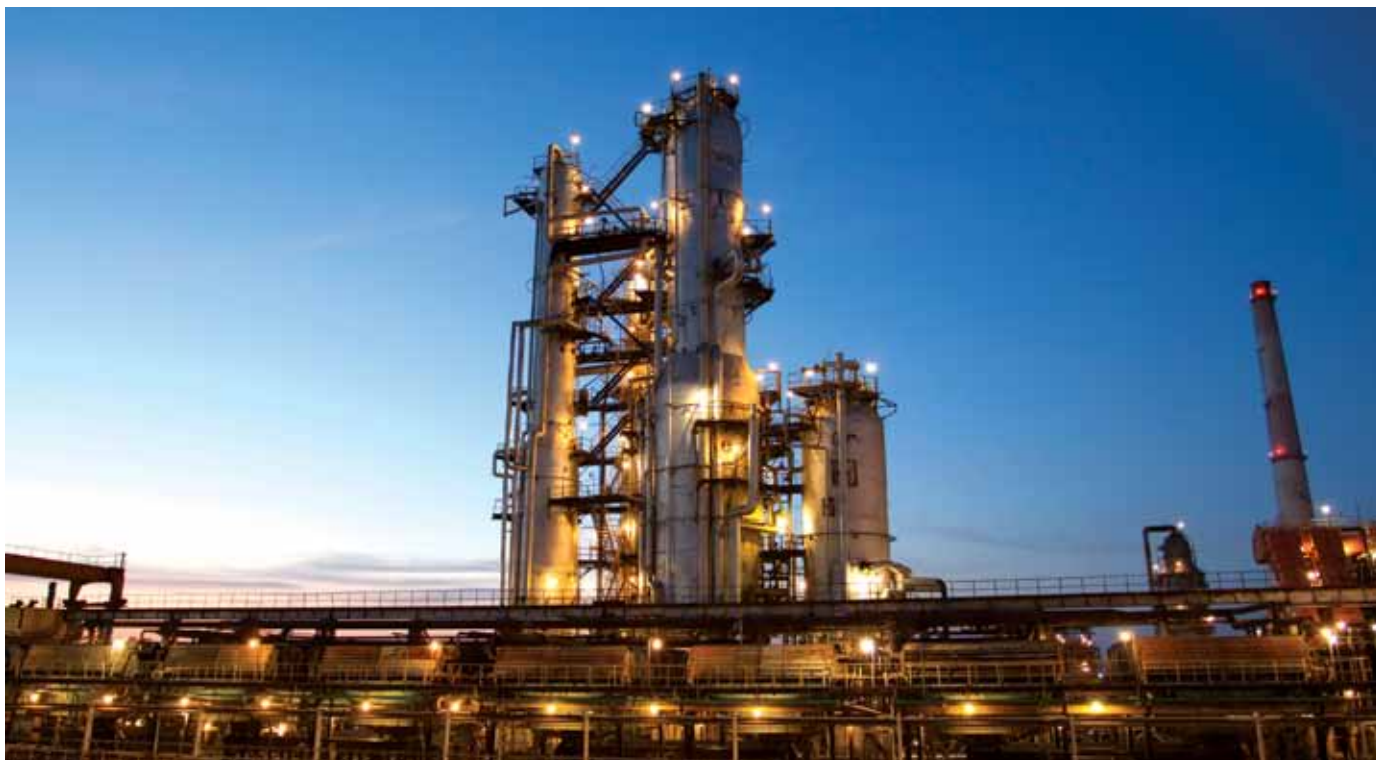
100 секциясының АТ блогі / Блок АТ секции 100 / Atmospheric distillation section of Unit-100
