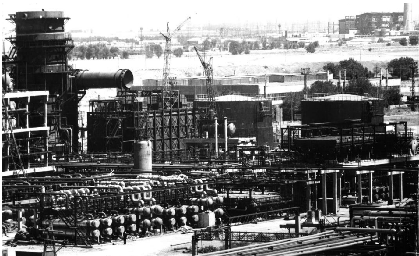
Мазутты вакуумды айдау қондырғысының құрылысы (МБАҚ), 1989 / Строительство установки вакуумной перегонки мазута (УВПМ), 1989 / Construction of Vacuum Distillation Unit (VDU), 1989
