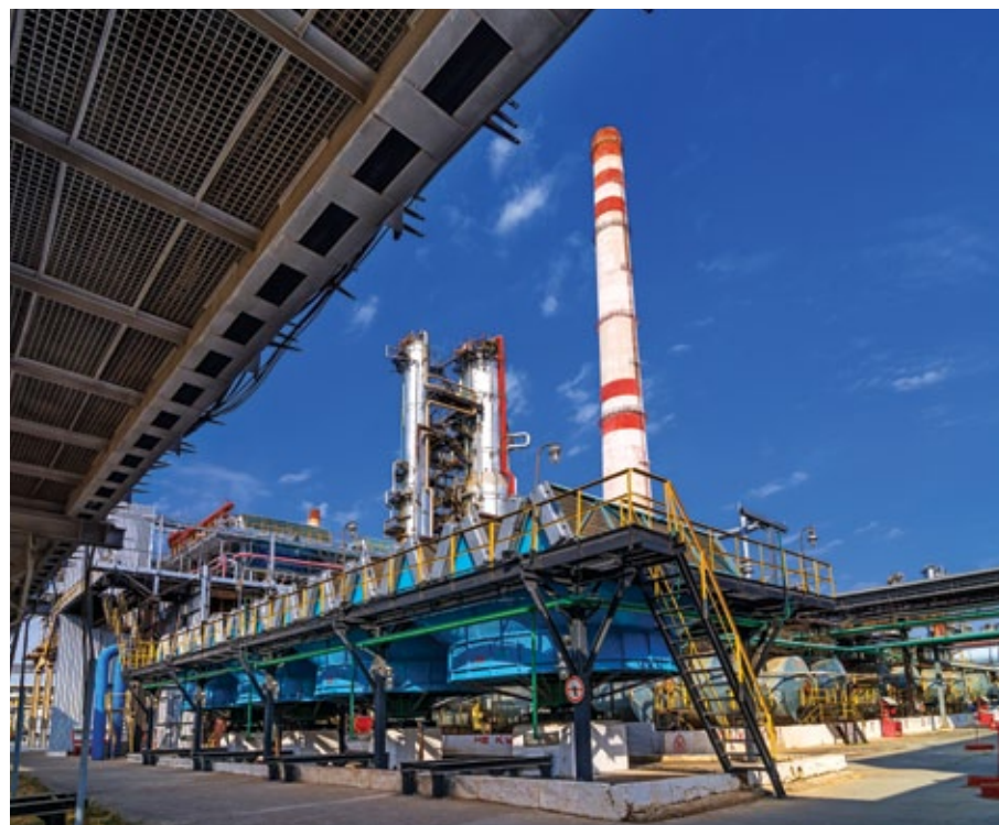
Висбрекинг қондырғысы, №2 цех / Установка висбрекинг, цех № 2 / Visbreaking Unit, Workshop No.2
