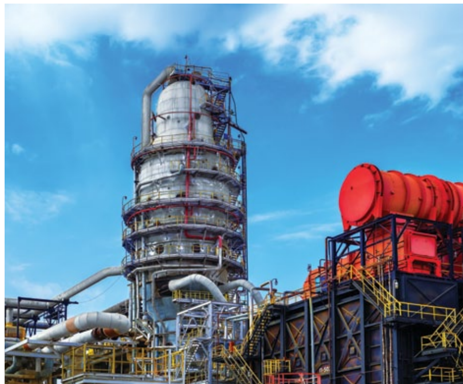
МБАҚ (мазутты вакуумды айдау қондырғысы) вакуум колоннасы, №2 цех, 2014 / Вакуумная колонна УВПМ (установка вакуумной перегонки мазута), цех №2, 2014 / Vacuum column of VDU (Vacuum Distillation Unit), Workshop No.2, 2014
