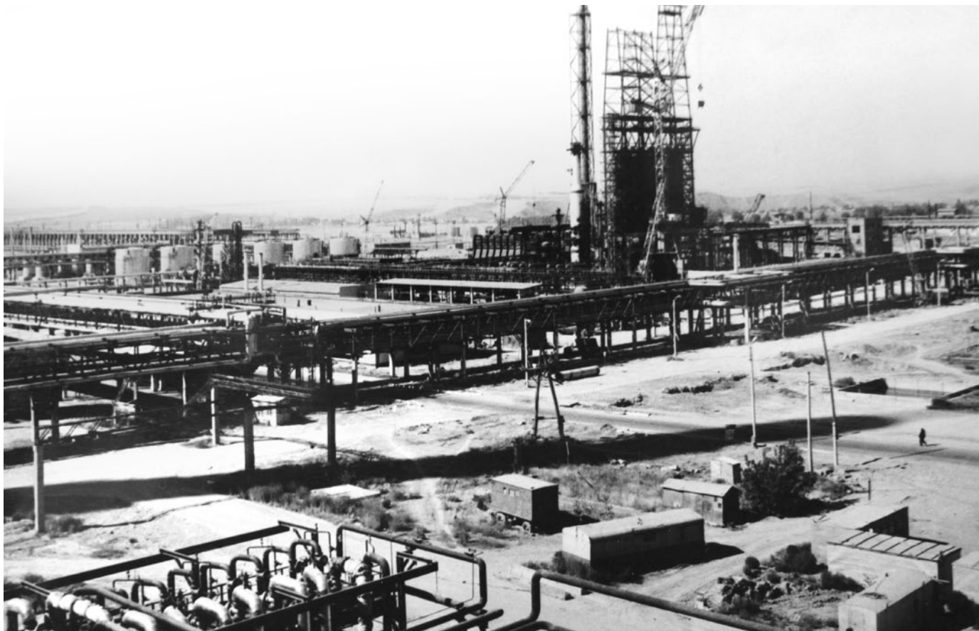
ШМӨЗ-дегі бөлігі №2 Висбрекинг қондырғысына айналған баяу кокстау қондырғысы / УЗК (установка замедленного коксования) ШНПЗ, часть которой была реконструирована в установку висбрекинг цеха №2 / Delayed coking unit at the Shymkent refinery, a part of which was later reconstructed into the Visbreaking Unit of the Workshop No.2
