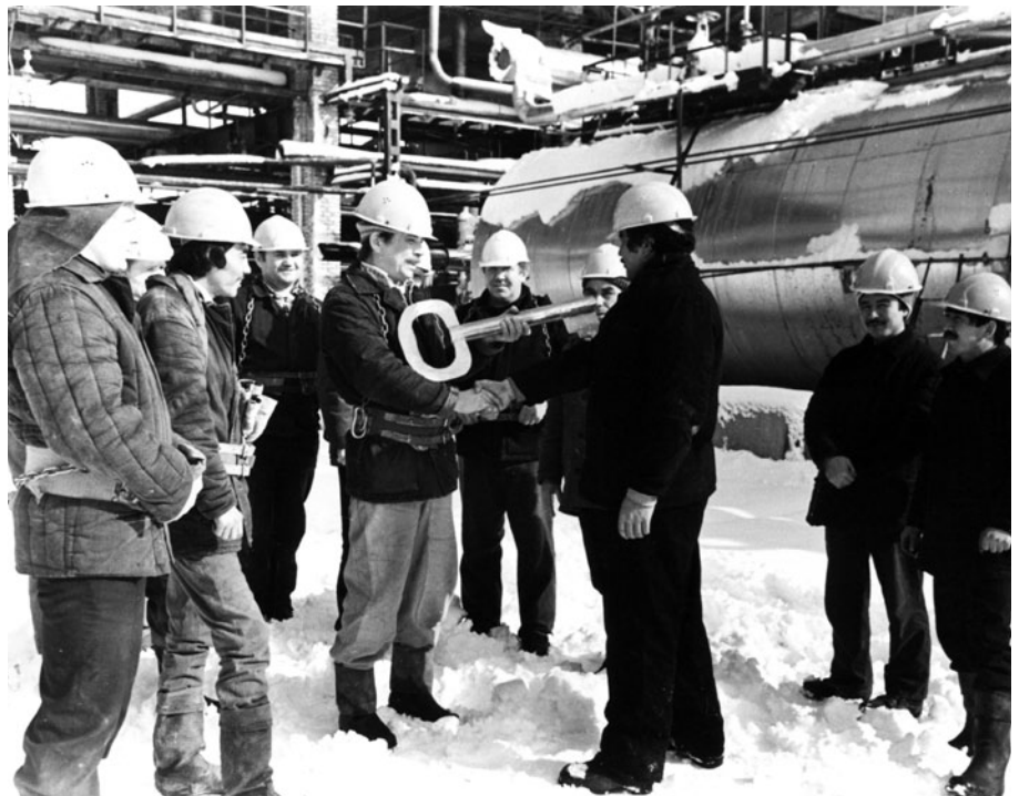
ШМӨЗ құрылысшылары символикалық кілт тапсыруда. 1985 / Строители вручают символический ключ ШНПЗ, 1985 / Builders hand over a symbolic key of the Shymkent refinery, 1985
