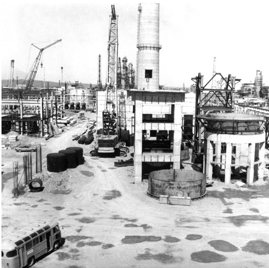
ЛК-6У цехи құрылысының алғашқы айлары, 1973 / Первые месяцы строительства цеха ЛК-6У, 1973 / The very first months of the LK-6U construction, 1973
