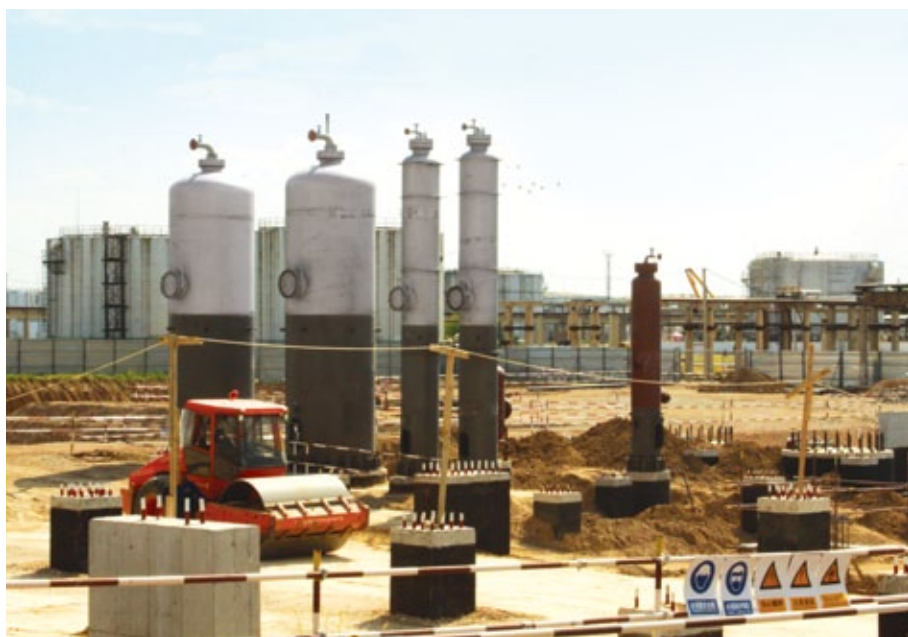
Изомеризация қондырғысының құрылысы, 2015 / Строительство установки изомеризации, 2015 / Construction of the Isomerisation Unit, 2015
