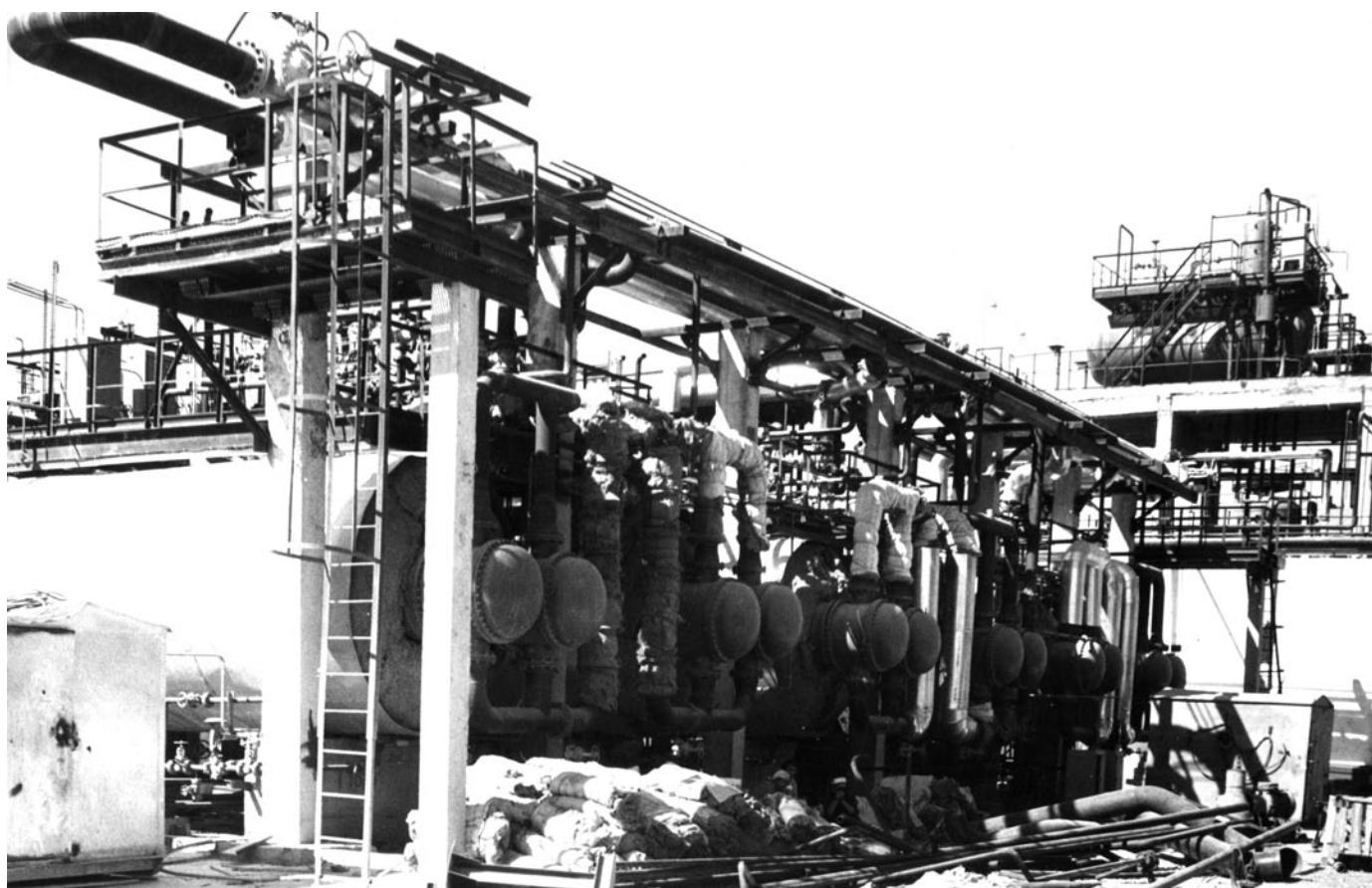
ЛК-6У құрылысы, 1973 / Строительство ЛК-6У, 1973 / LK-6U construction, 1973
