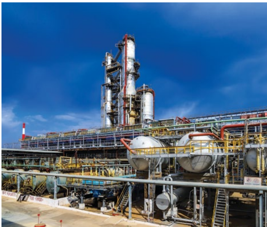
ЭЛТҚ-АҚ (мұнайды атмосфералық айдау және электрмен тұзсыздандыру қондырғысы) ЛК-6У қондырғысының 100 секциясы / ЭЛОУ-АТ (электрообессоливающая установка атмосферной перегонки), секция 100, установка ЛК-6У / CDU (Crude Distillation Unit) Unit-100, LK-6U
