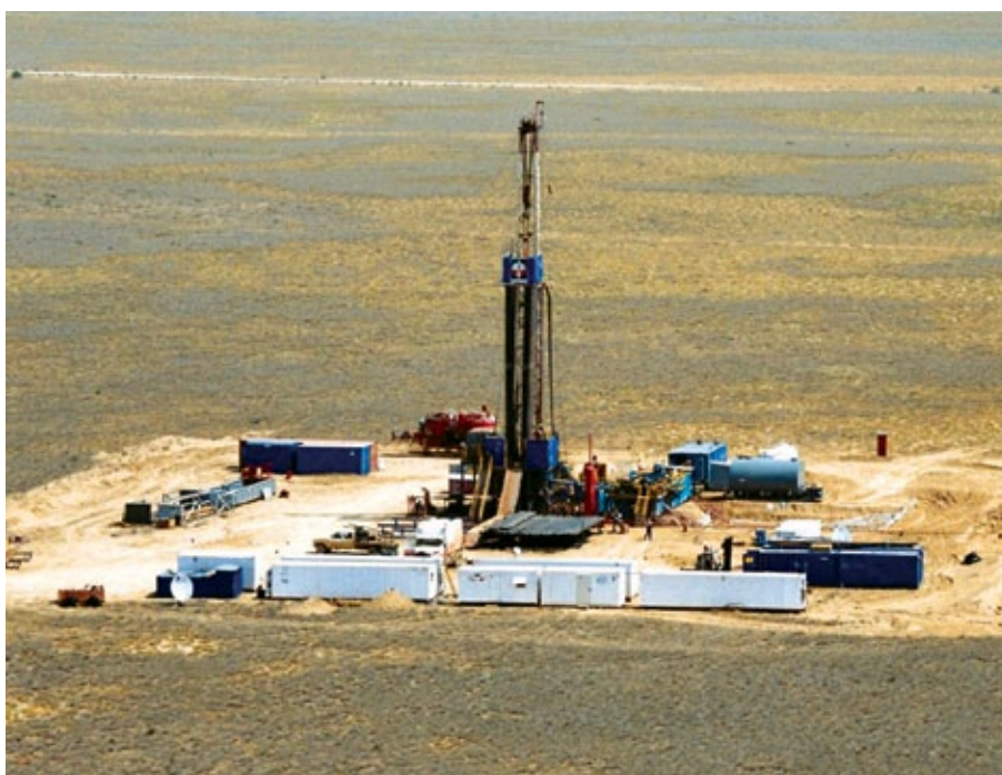
КРЕМКО-900 бұрғылау қондырғысы / Буровая установка КРЕМКО-900 / KREMKO-900 drilling rig
