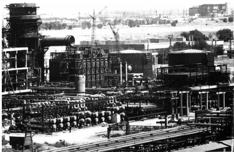
Мазутты вакуумды айдау қондырғысының құрылысы (МБАҚ), 1989 / Строительство установки вакуумной перегонки мазута (УВПМ), 1989 / Construction of Vacuum Distillation Unit (VDU), 1989
